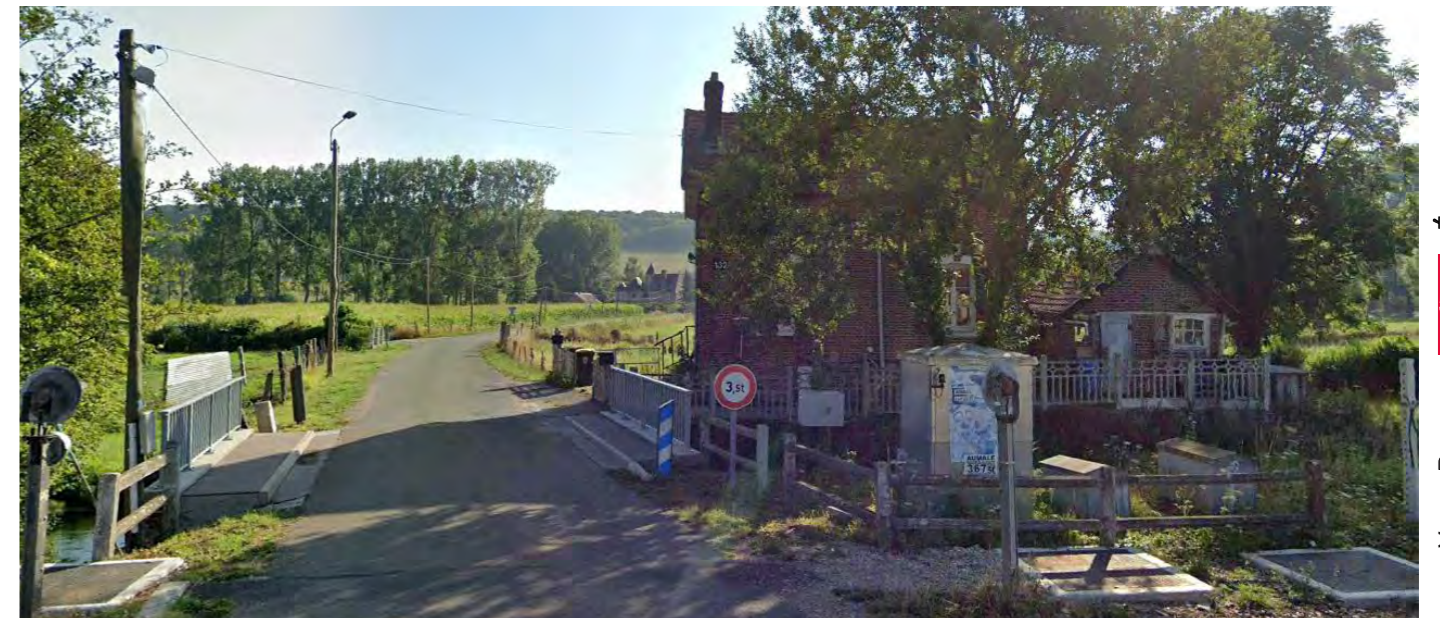
Photo 31 : Ambiance paysagère - Voie ferrée dans le creux de la vallée de la Bresle à proximité de Caqueville
