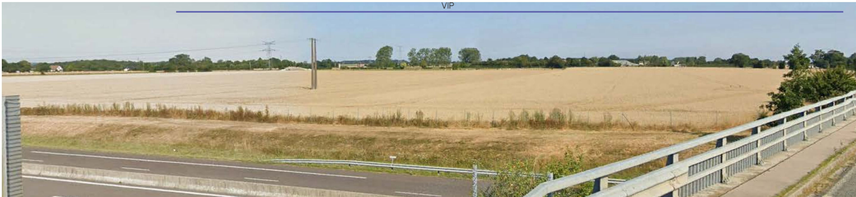
Photo 72 : Depuis le croisement de l'autoroute A29 et de la RD 1015, les vues en direction du VIP sont ouvertes
